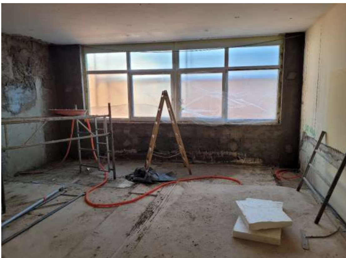
Slika 8 Prenova električne inštalacije 07.12.2022
