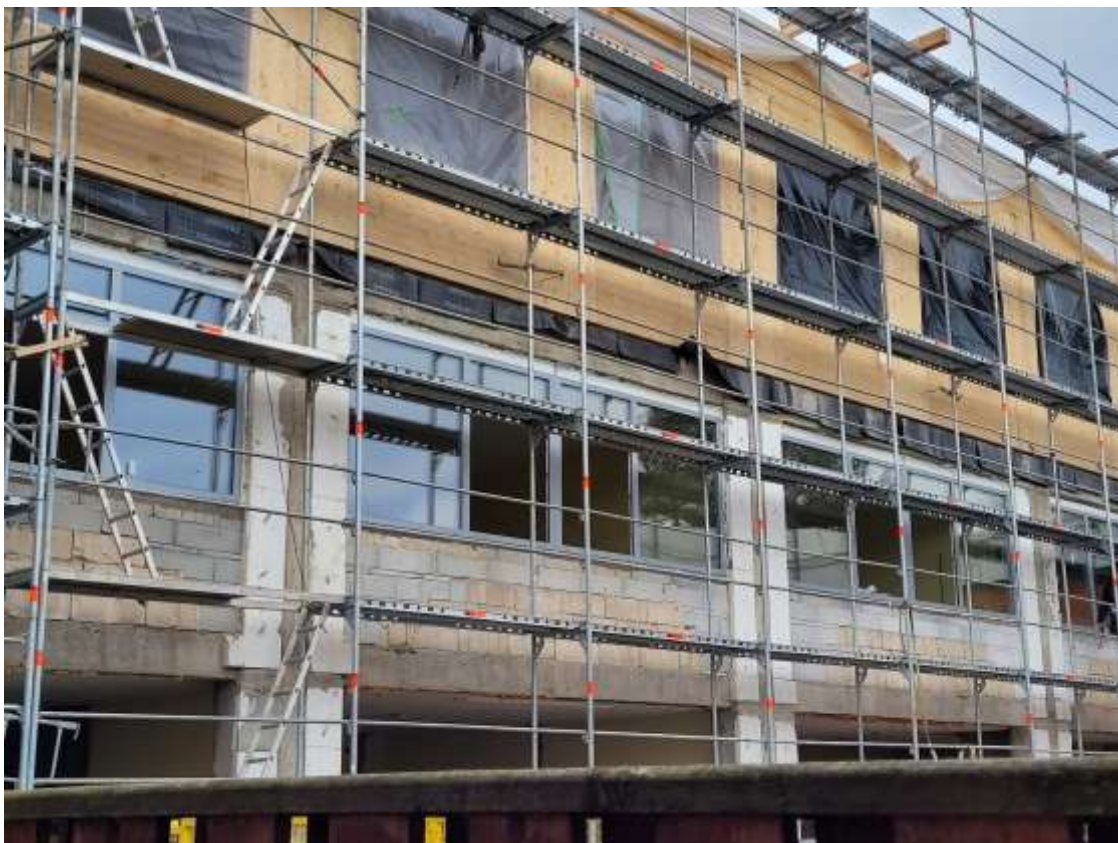
Slika 6 Montaža oken v učilnicah prvega nadstropja 28.11.2022
