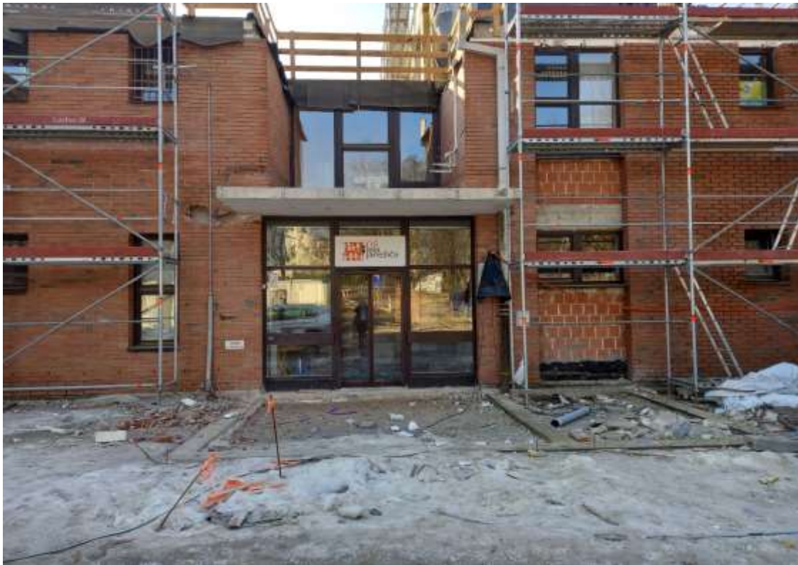
Slika 3 Temeljna plošča stopnišča 13.02.2023
