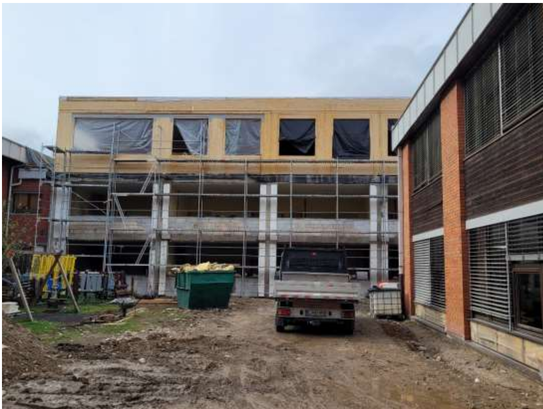
Slika 4 Priprava na montažo oken 11.11.2022
