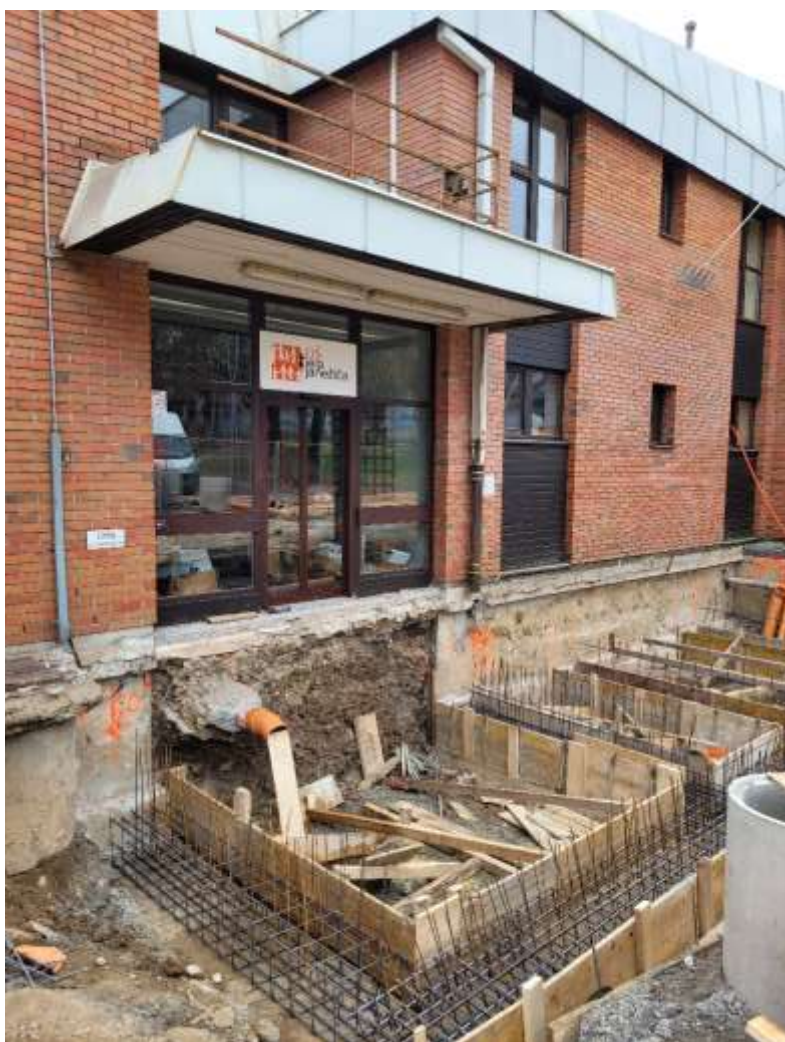
Slika 2 Priprava za vlitje temeljne plošče stopnišča 05.12.2022
