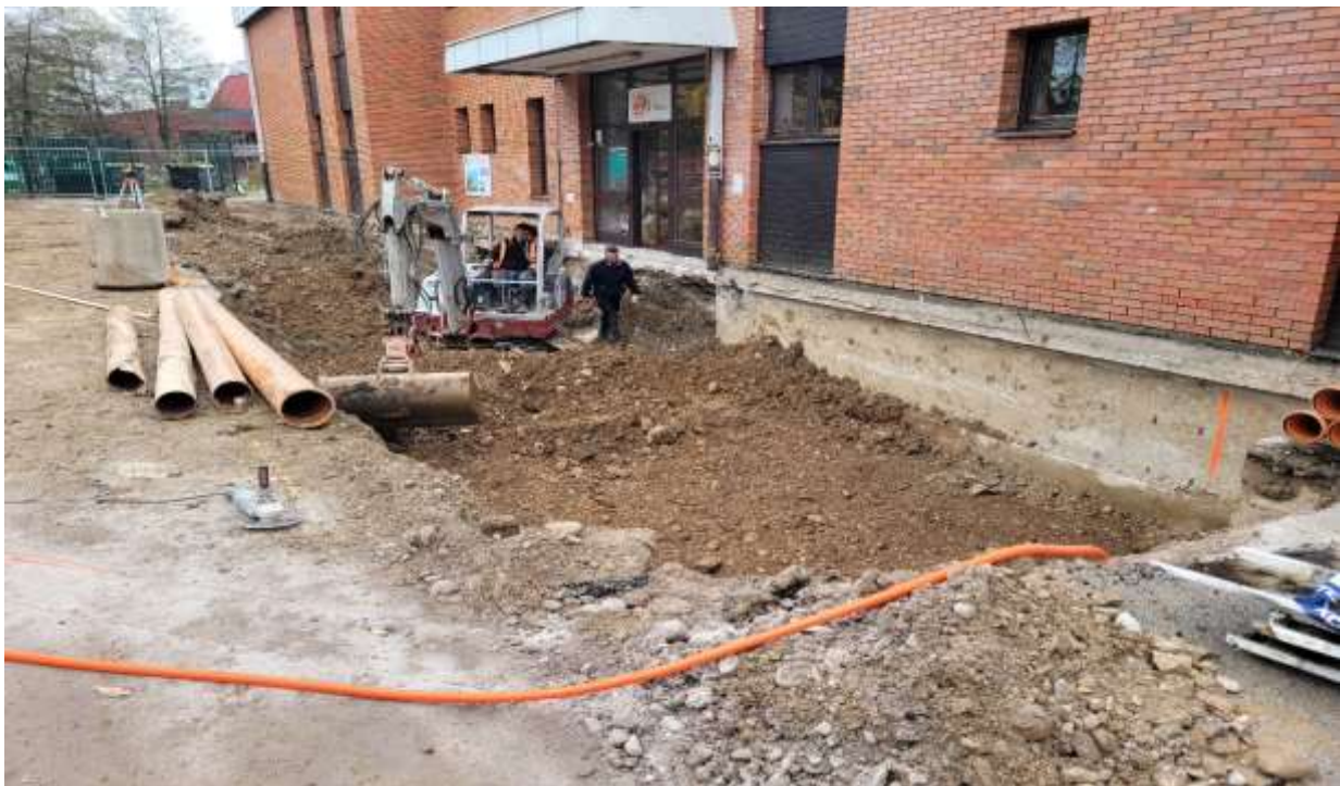
Slika 1 Izkop pred glavnim vhodom 21.11.2023
