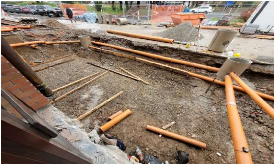
Slika 1 Prestavitev kanalizacijskih cevi 22.11.2022
