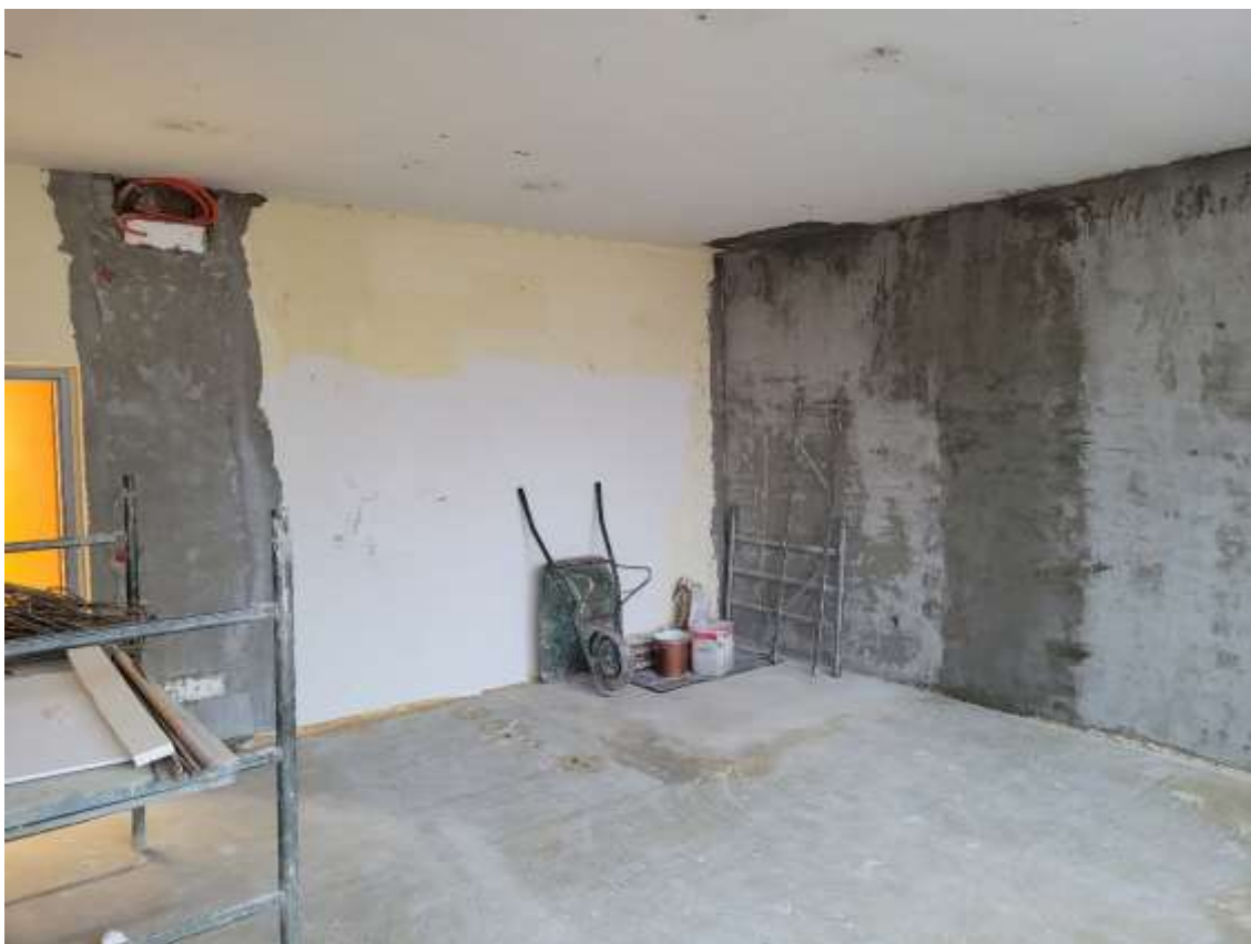
Slika 9 Prenova učilnic v prvem nadstropju 24.12.2022
