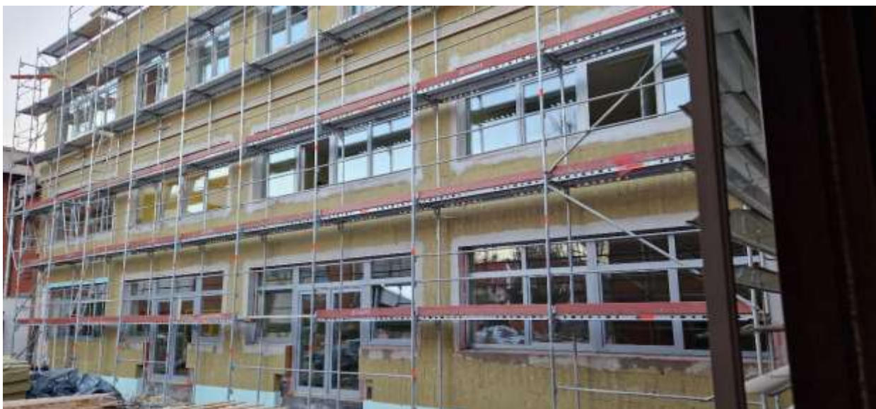
Slika 13 Narejena obloga vzhodne stene šole (vključno z nadzidom) 3.2.2023
